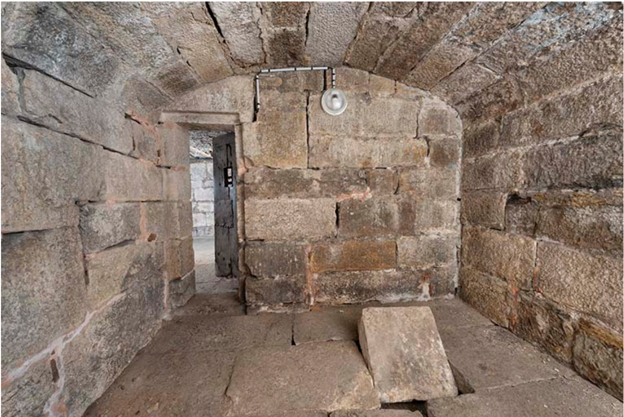
Intérieur d'une cellule.
