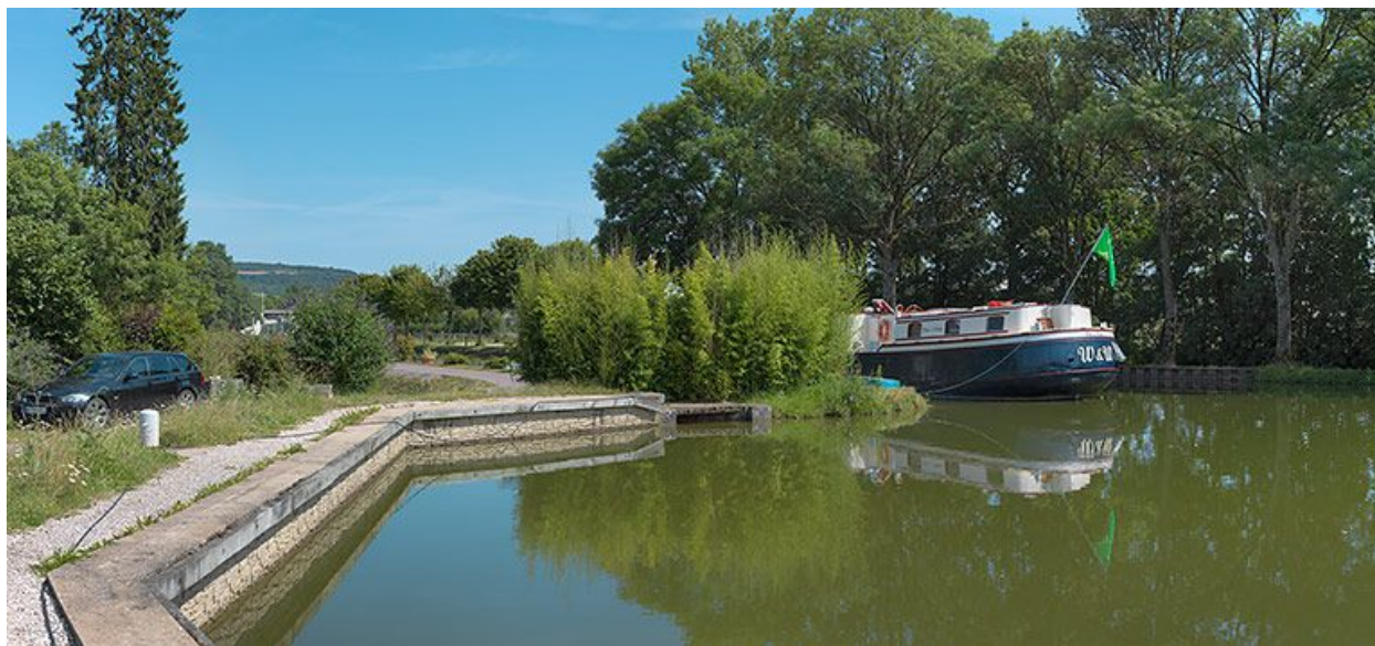
Déversoir du port rive gauche.
