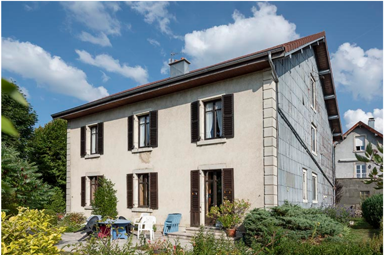
Maison : façade postérieure, de trois quarts droite.
