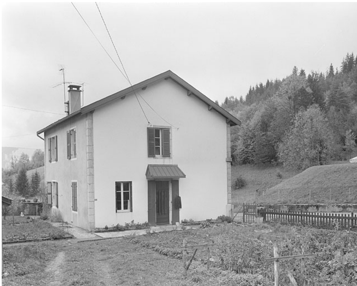
Façade postérieure et face nord-est.
