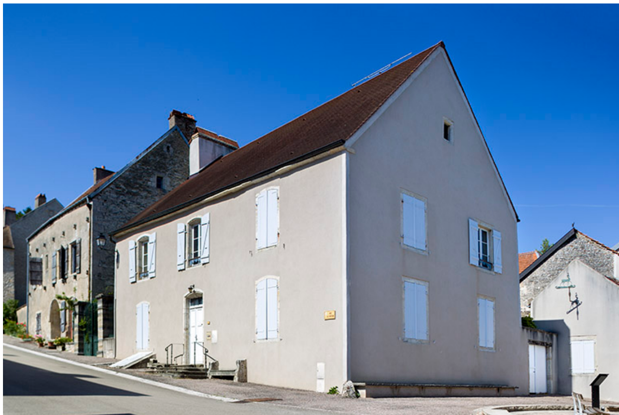
Vue générale de trois quart droite.
