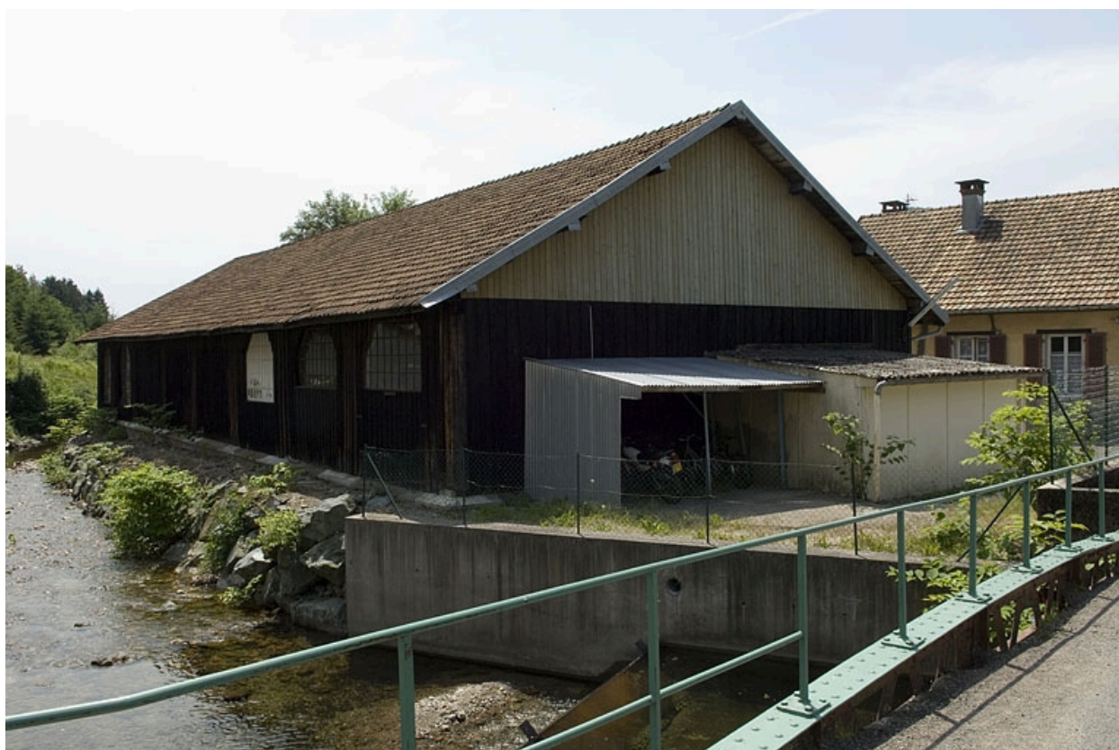
Magasin industriel (rive droite du Breuchin).
