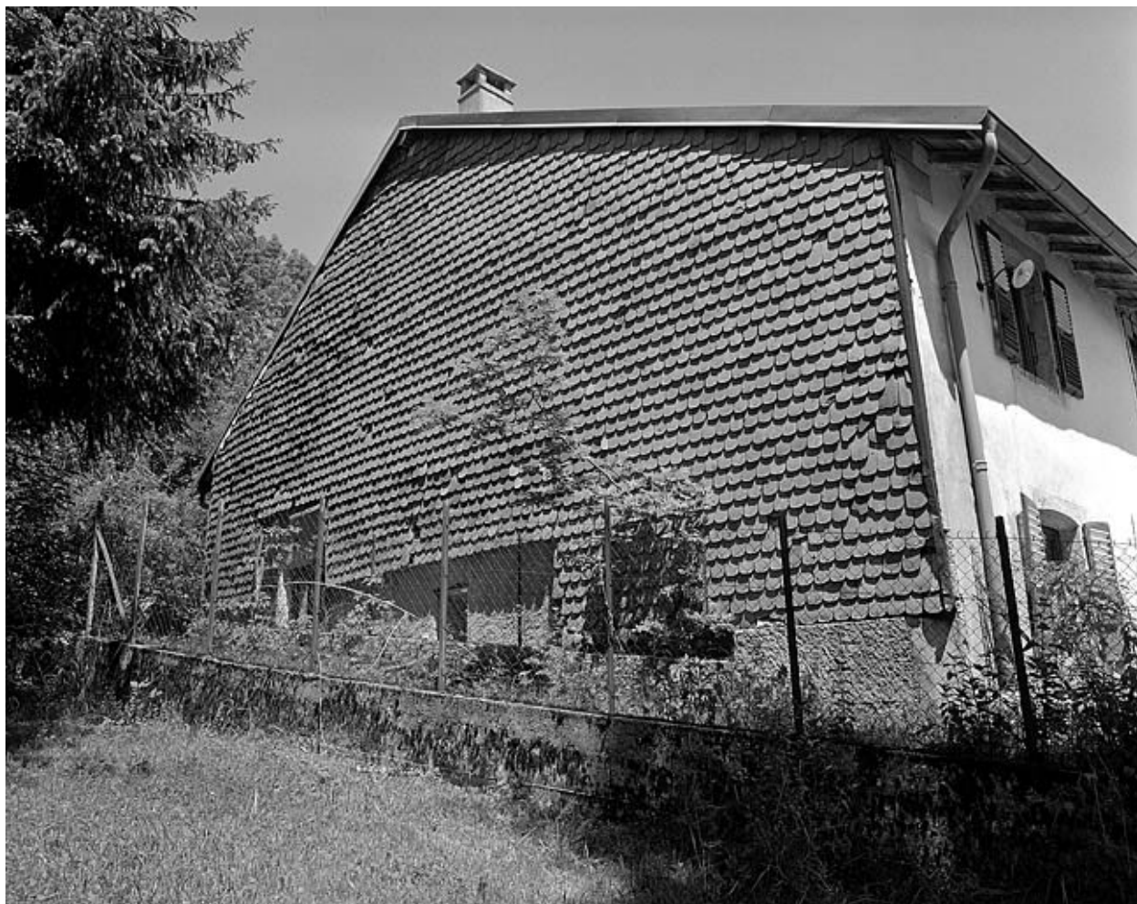
Essentage de tuiles sur un pignon sud-ouest.
