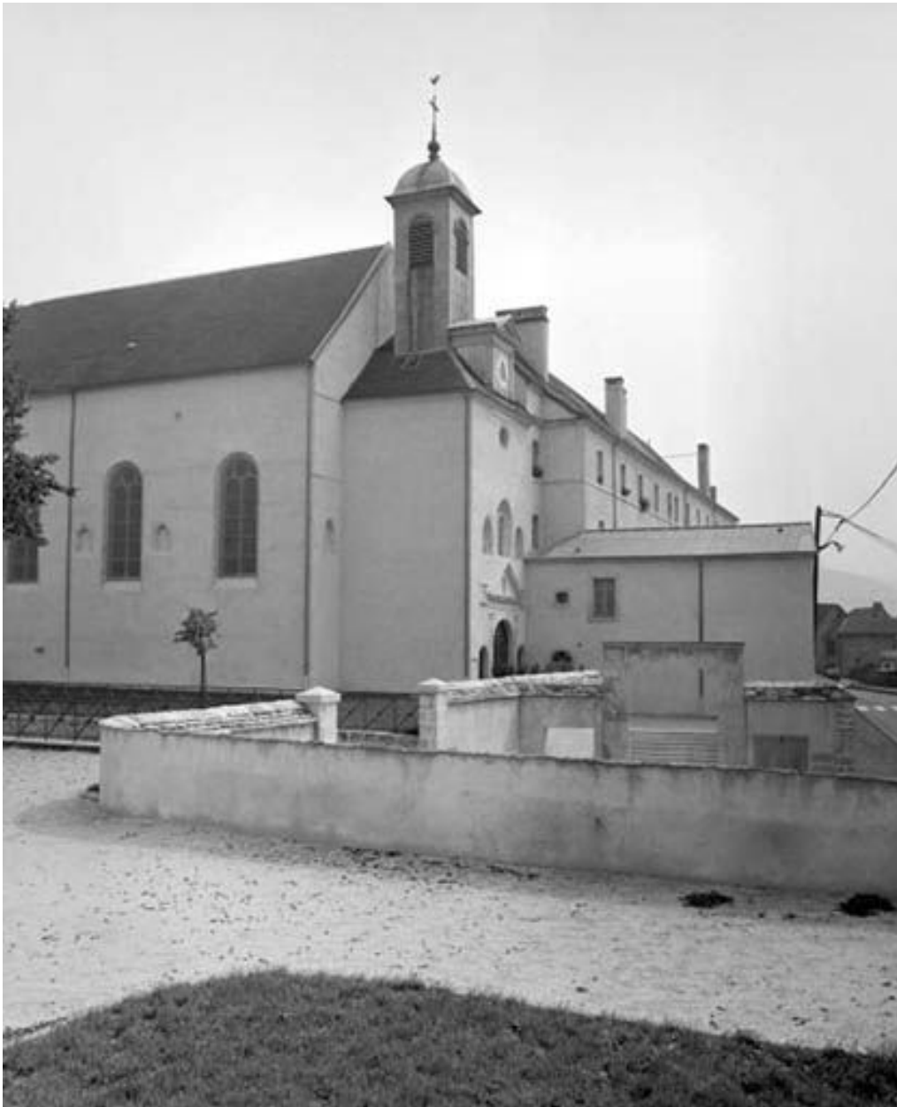
Façade antérieure et façade latérale gauche de la chapelle après la rénovation de 1981-1983.
