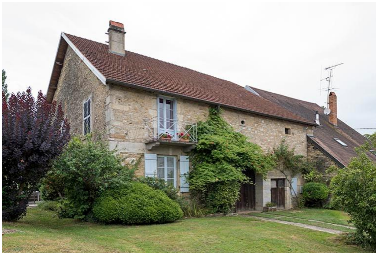
Façade sur rue de trois-quart
