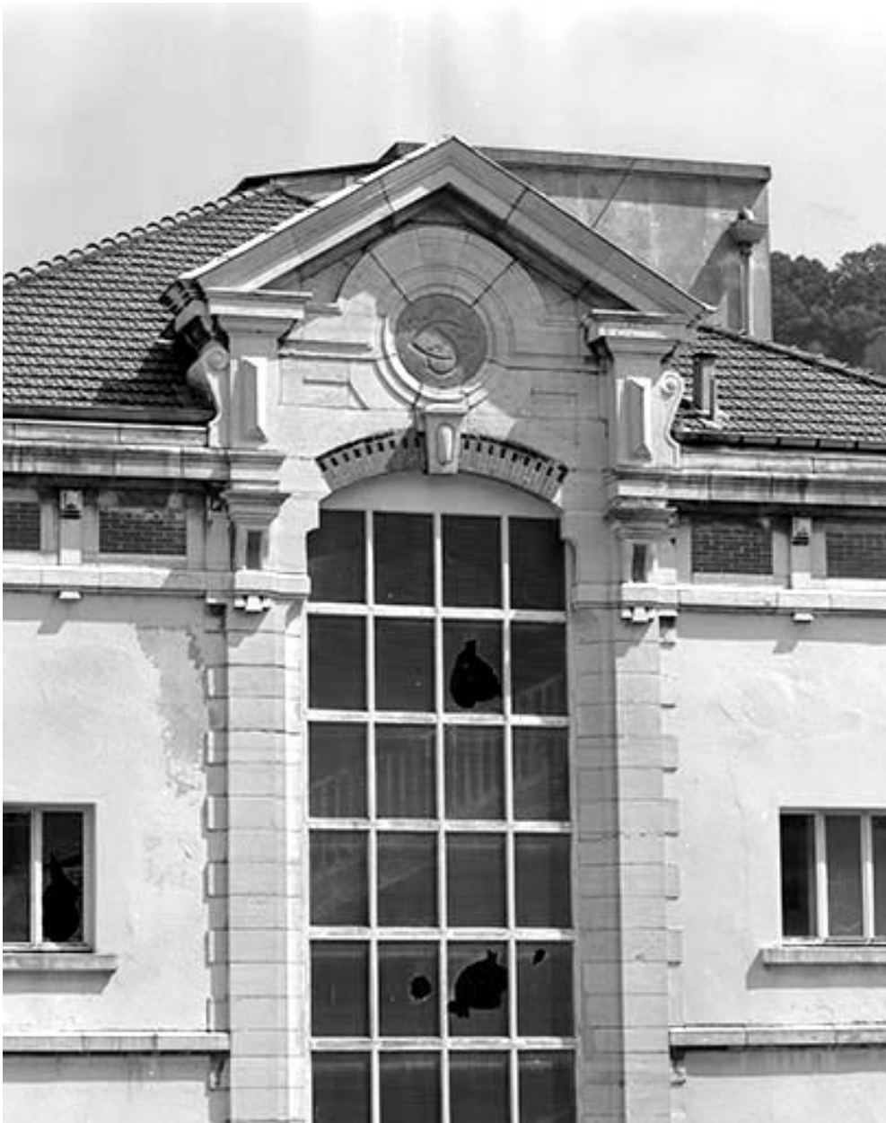
Baie centrale en façade de la cantine.
