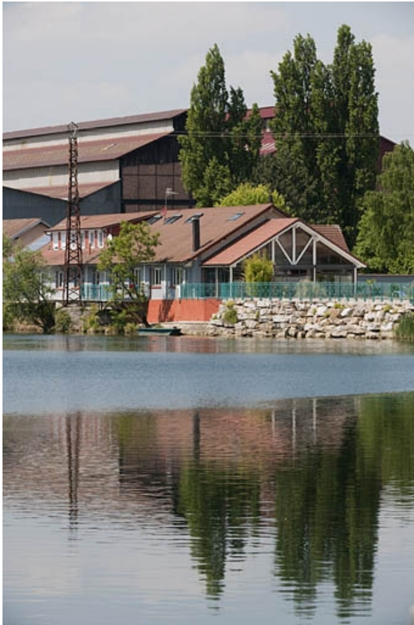
Pignons de l'aciérie et magasins industriels depuis le sud-est.
