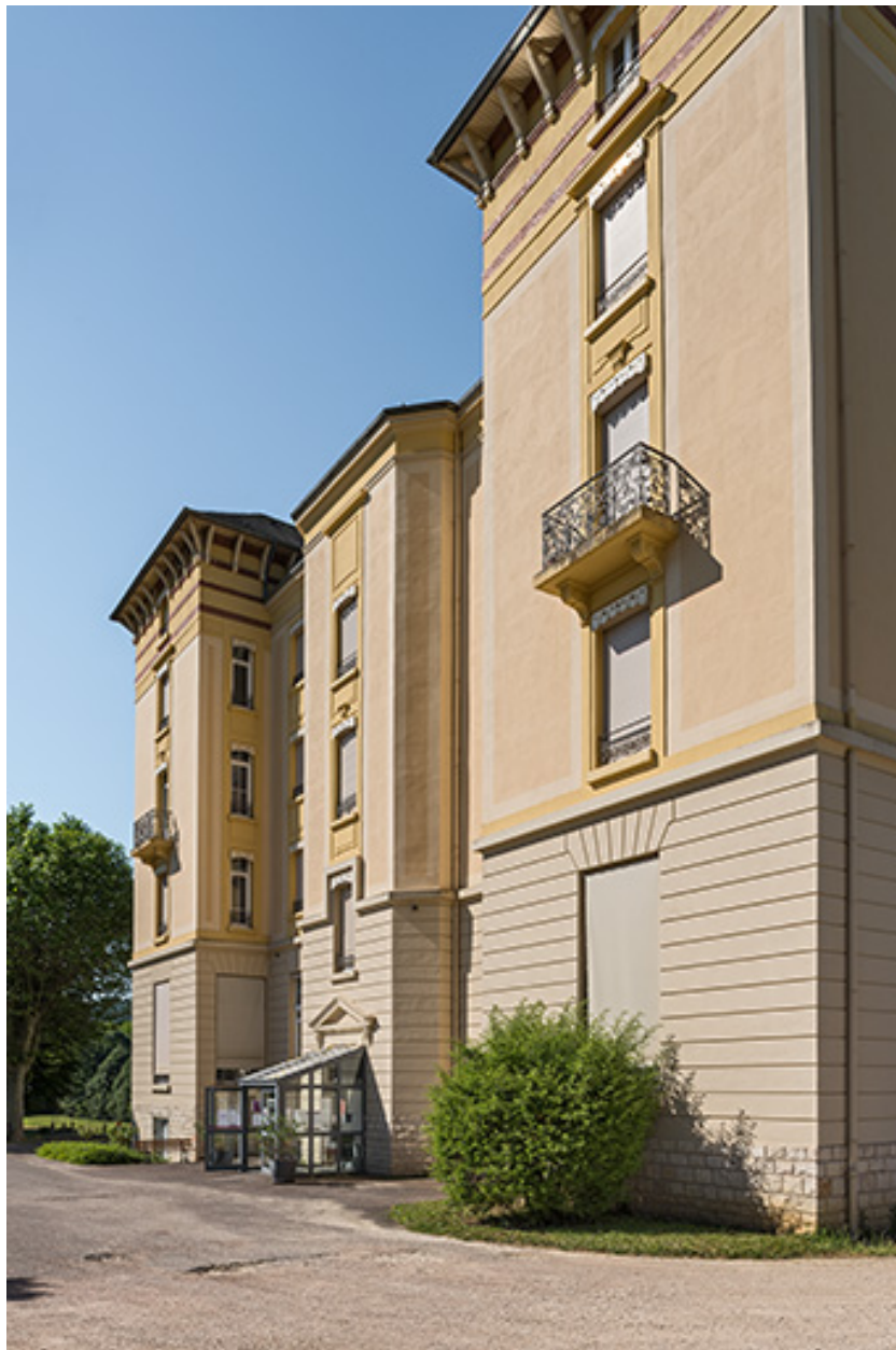
Façade nord-est avec l'entrée de l'escalier.
