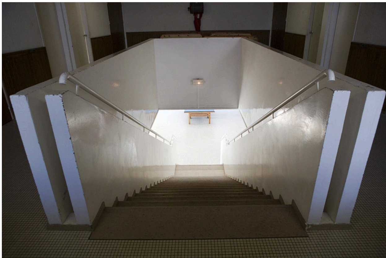
Escalier intérieur : la rampe béton.
