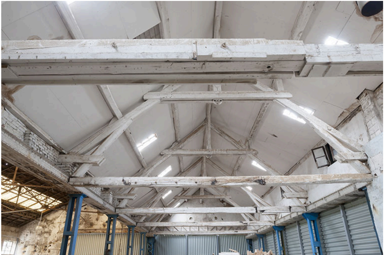
Charpente de l'atelier d'usinage.
