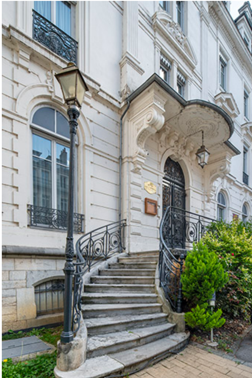
Façade sur l'avenue Carnot, entrée avec perron.
