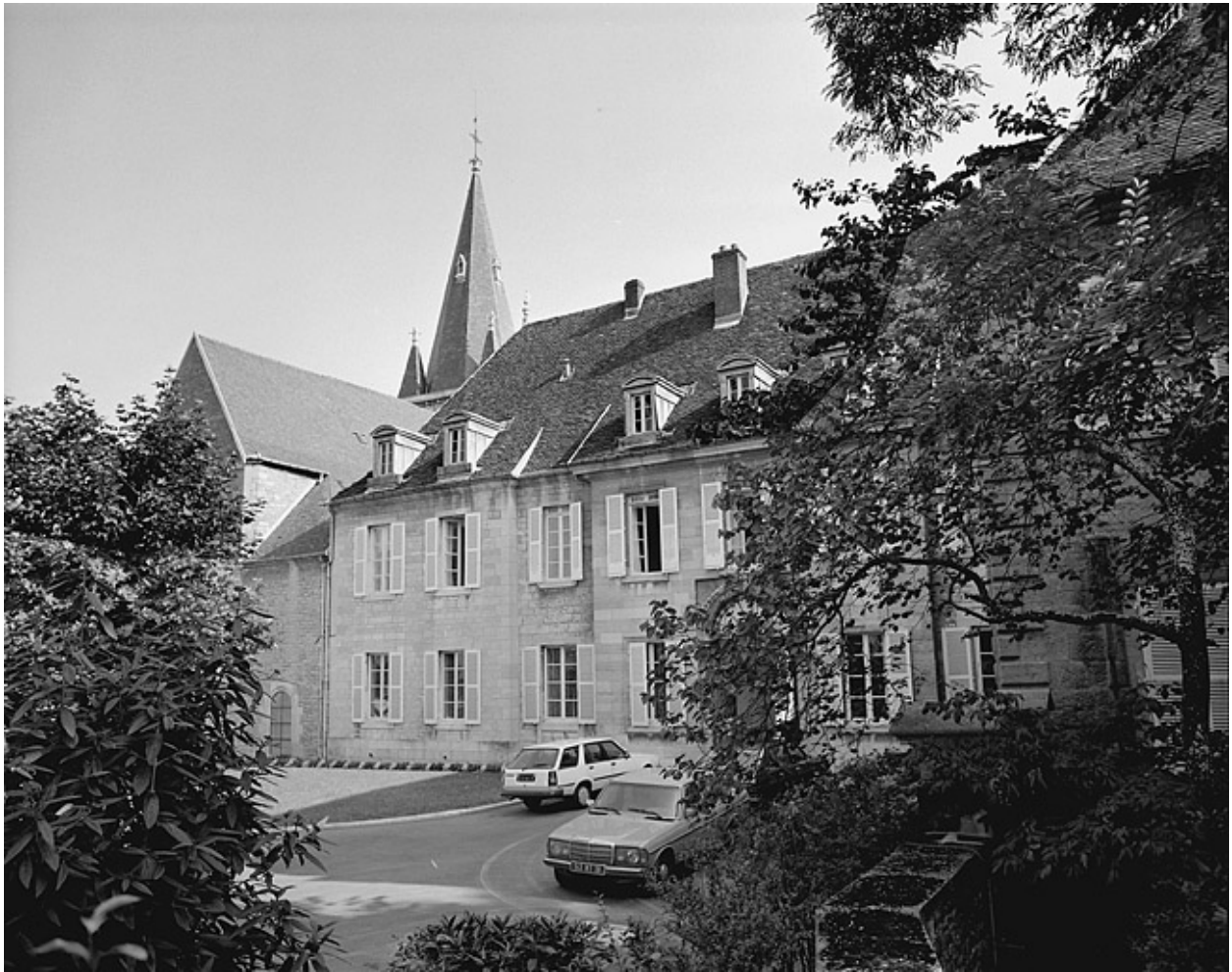
Cour d'honneur : détail du bâtiment.
