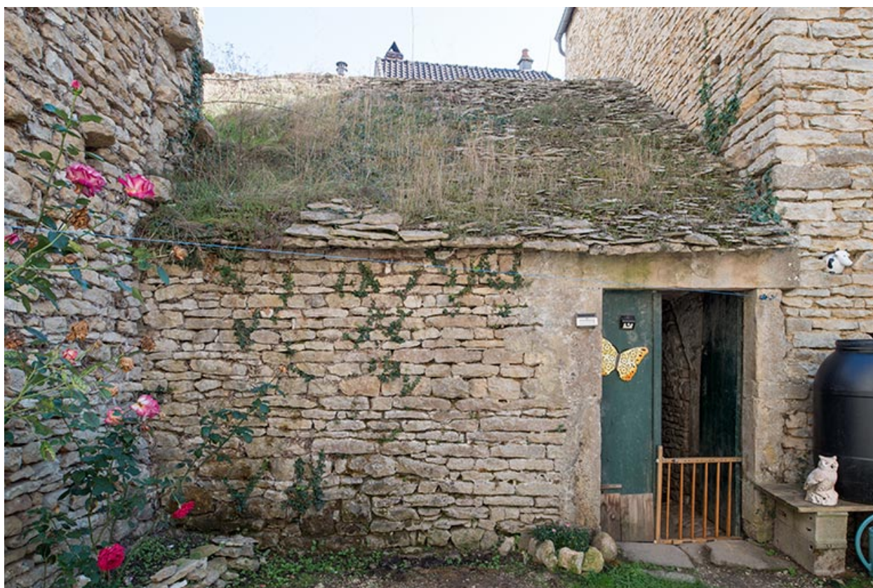
Le bâtiment de face, depuis la cour.
