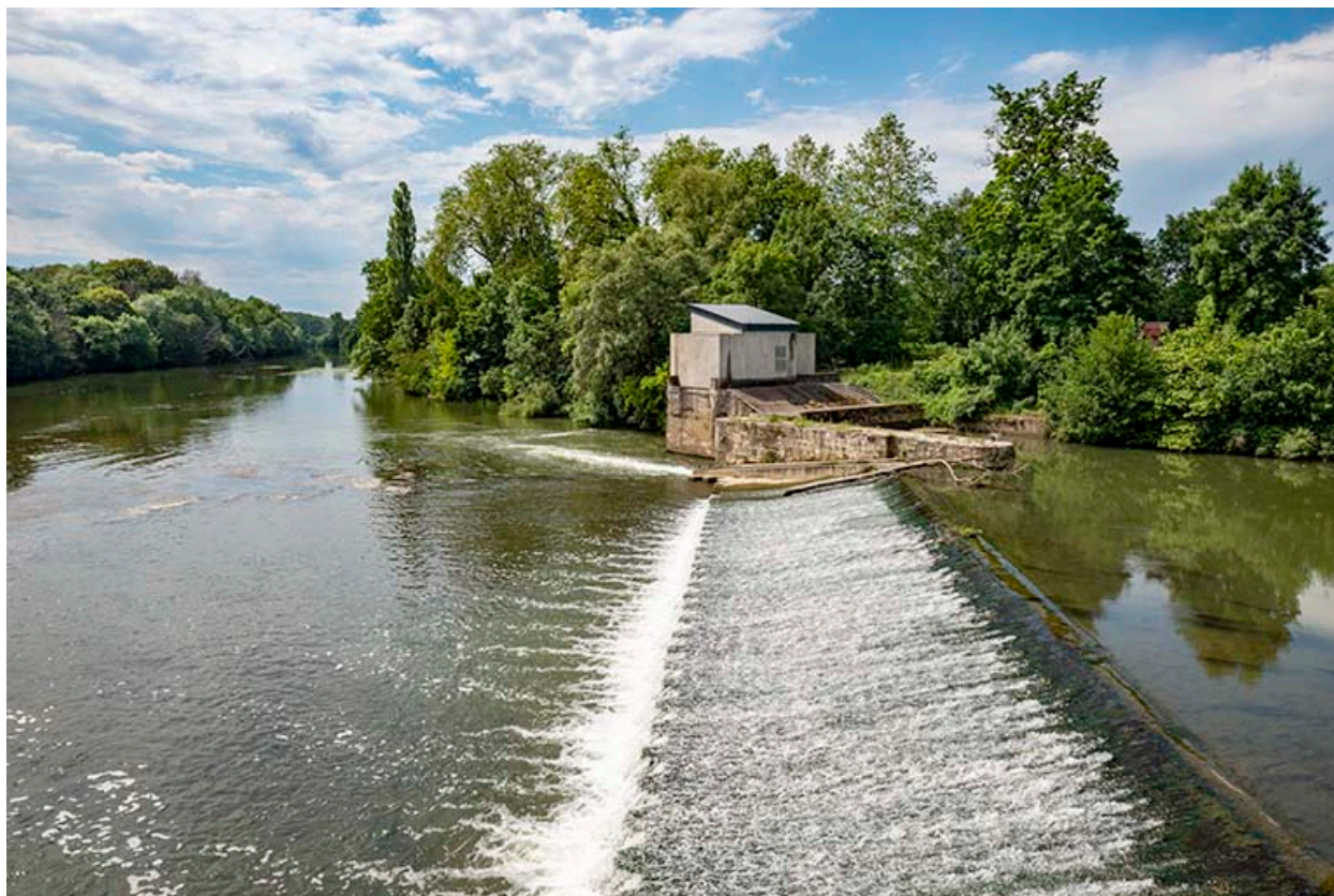
Vue générale sur le déversoir.
