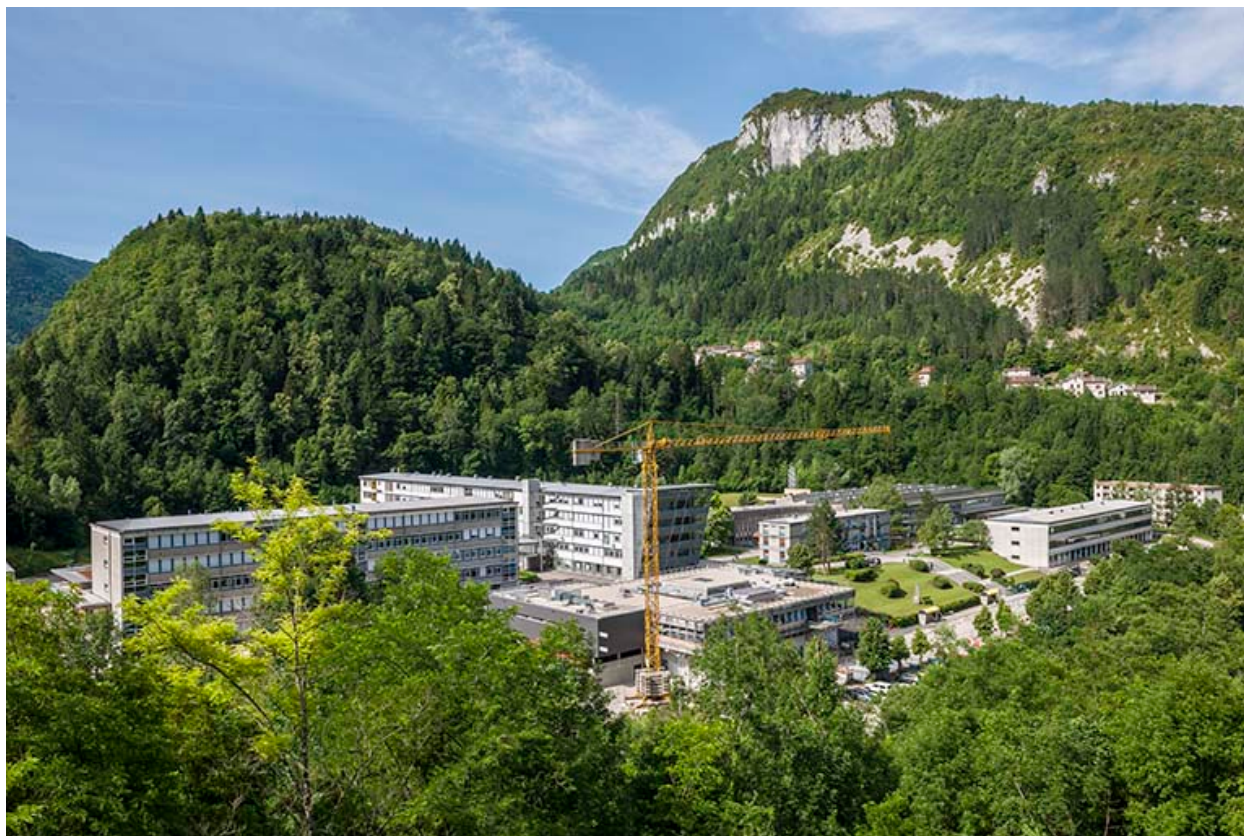
Vue d'ensemble de la cité scolaire.
