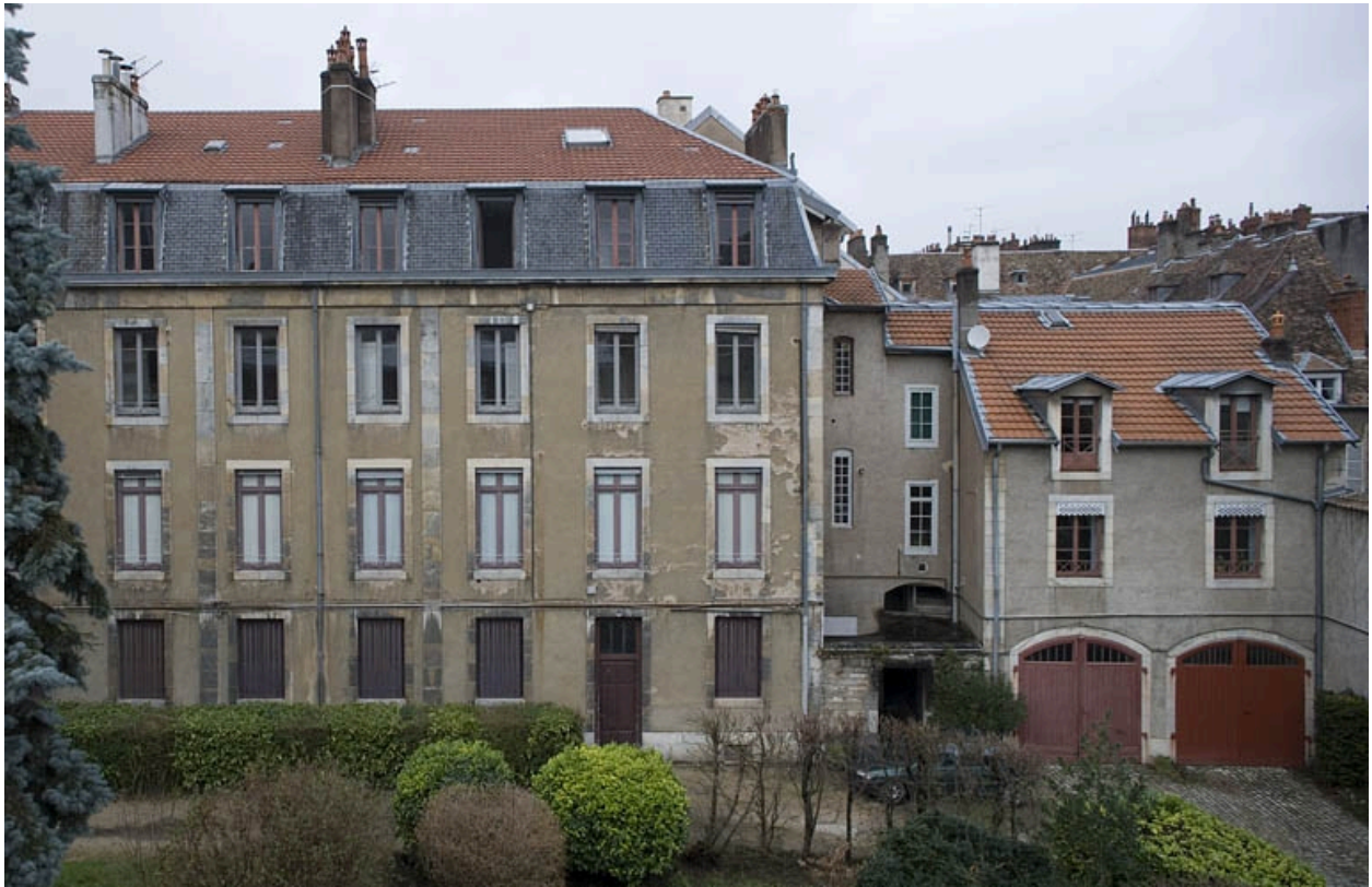
Vue d'ensemble de l'aile à gauche de la cour, de face.
