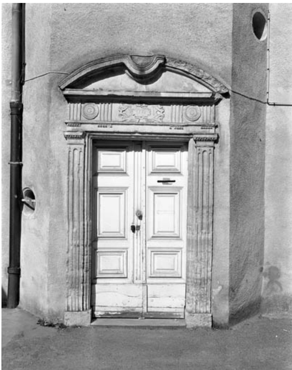
Détail de la porte d'entrée de l'escalier.
