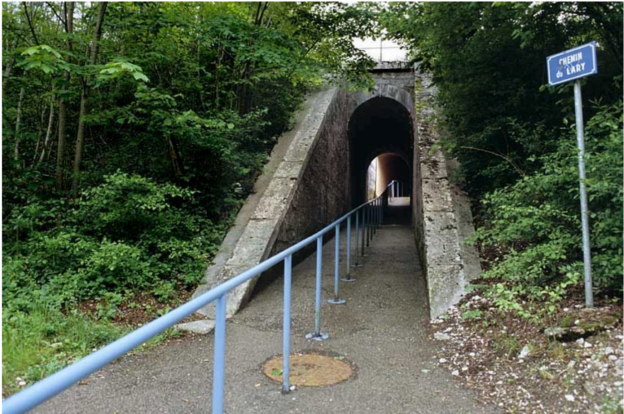
Vue d'ensemble de la tête aval (nord).
