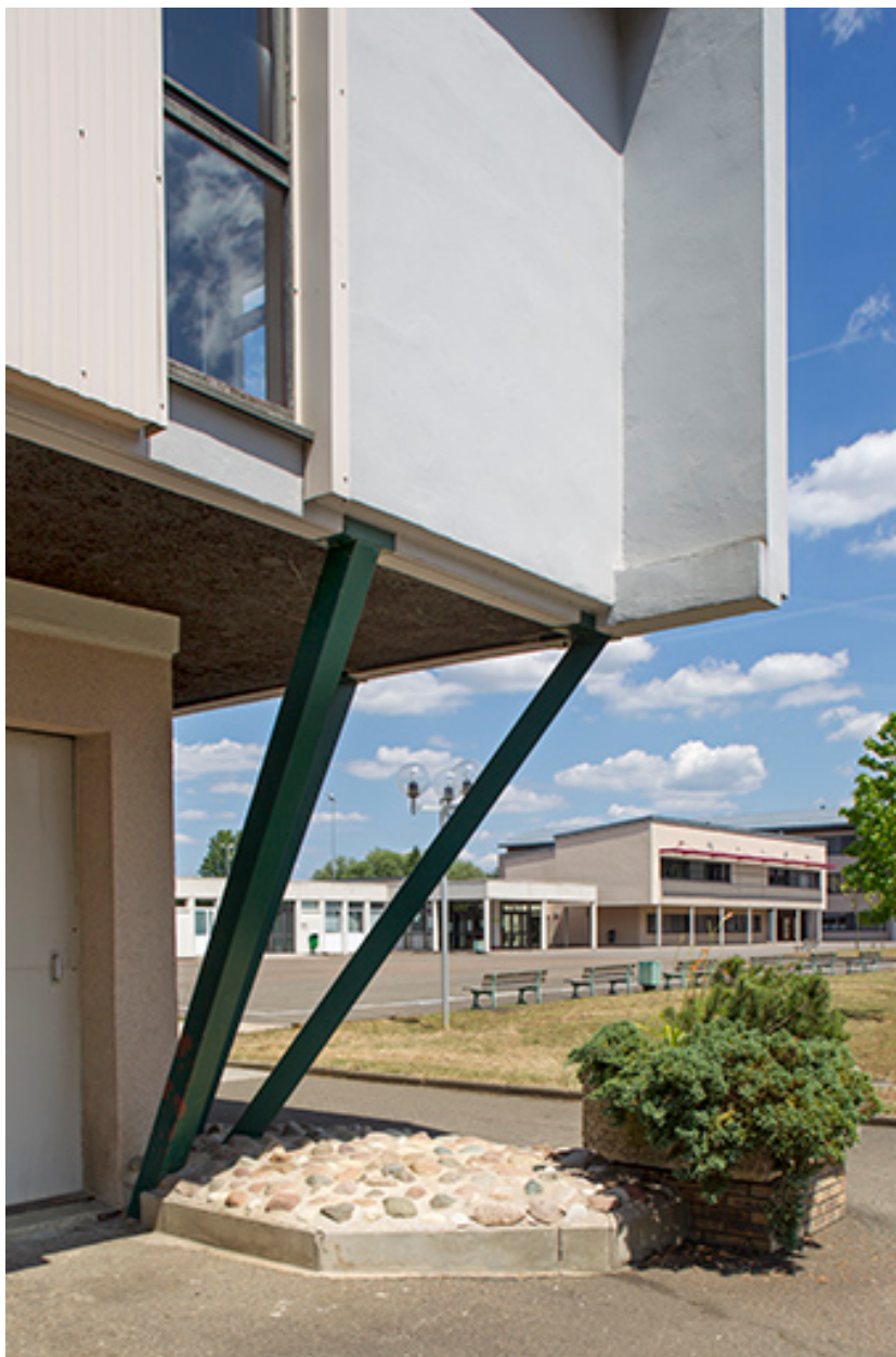
D tail de l'angle sud-est de la cantine.
