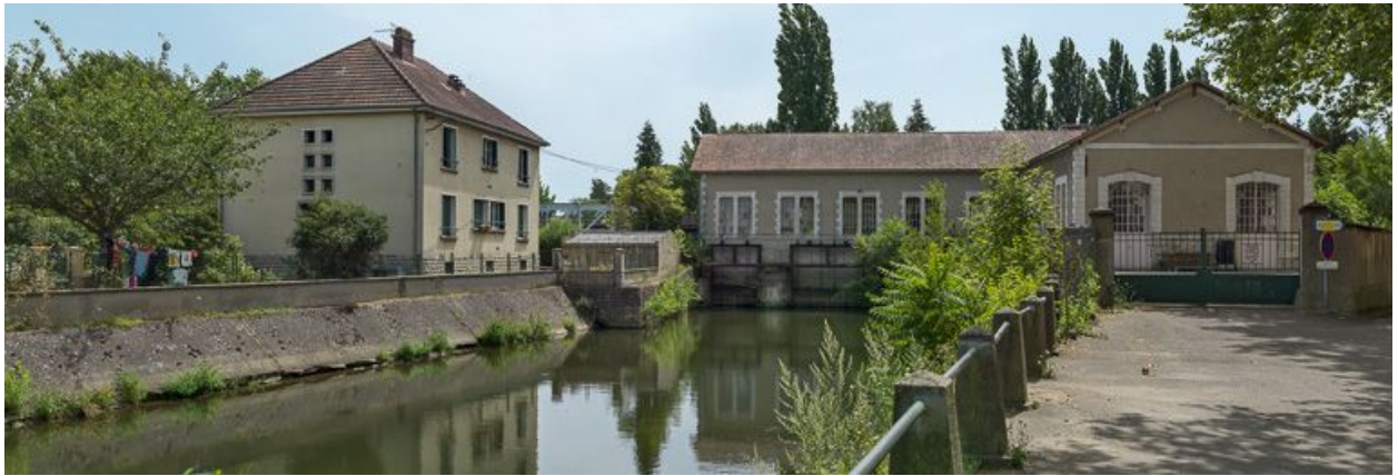
Auxerre, le moulin du Batardeau et le bief de dérivation. A gauche, l'arrière de la maison éclusière.
