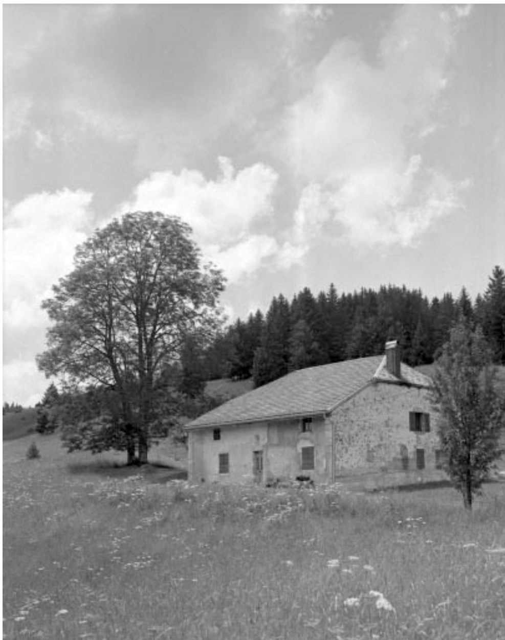
Façade antérieure et face droite.
