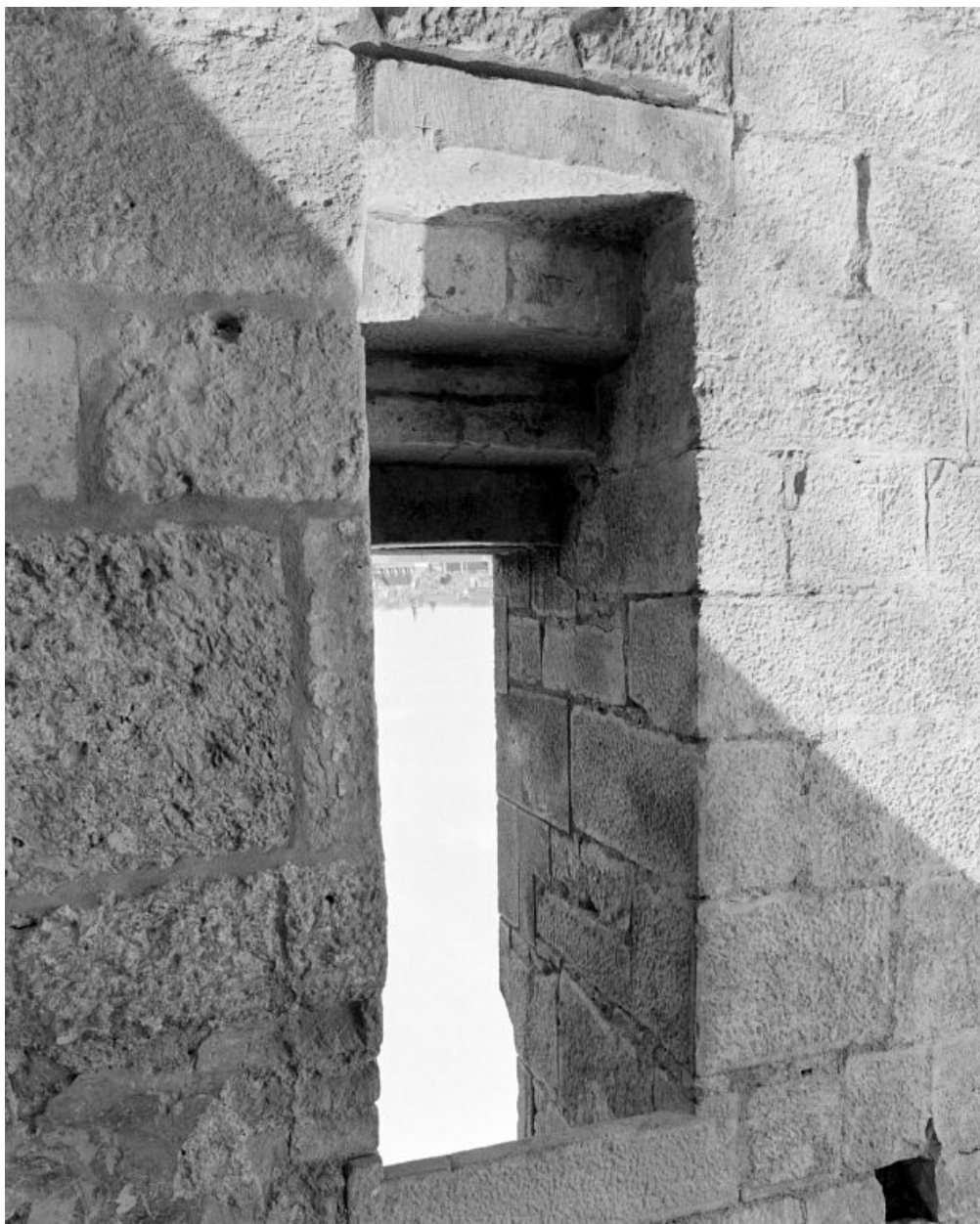
Façade : porche, vestiges d'escalier (mur gauche)
