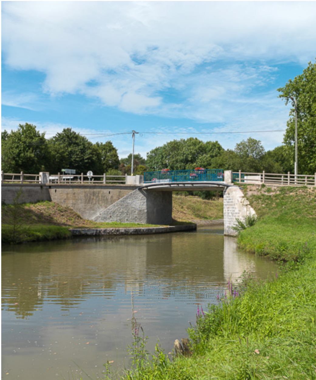
Vue d'ensemble du pont.
