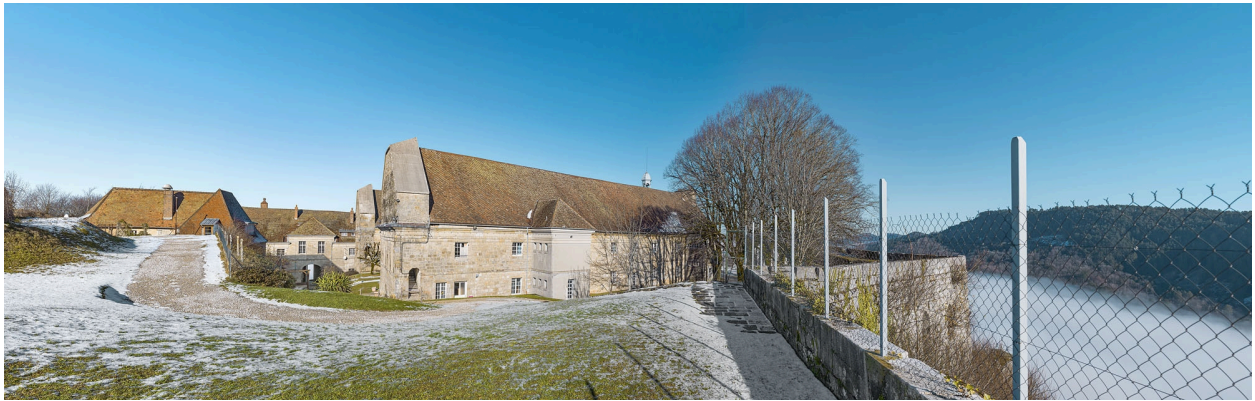
Vue intérieure depuis le sud.
