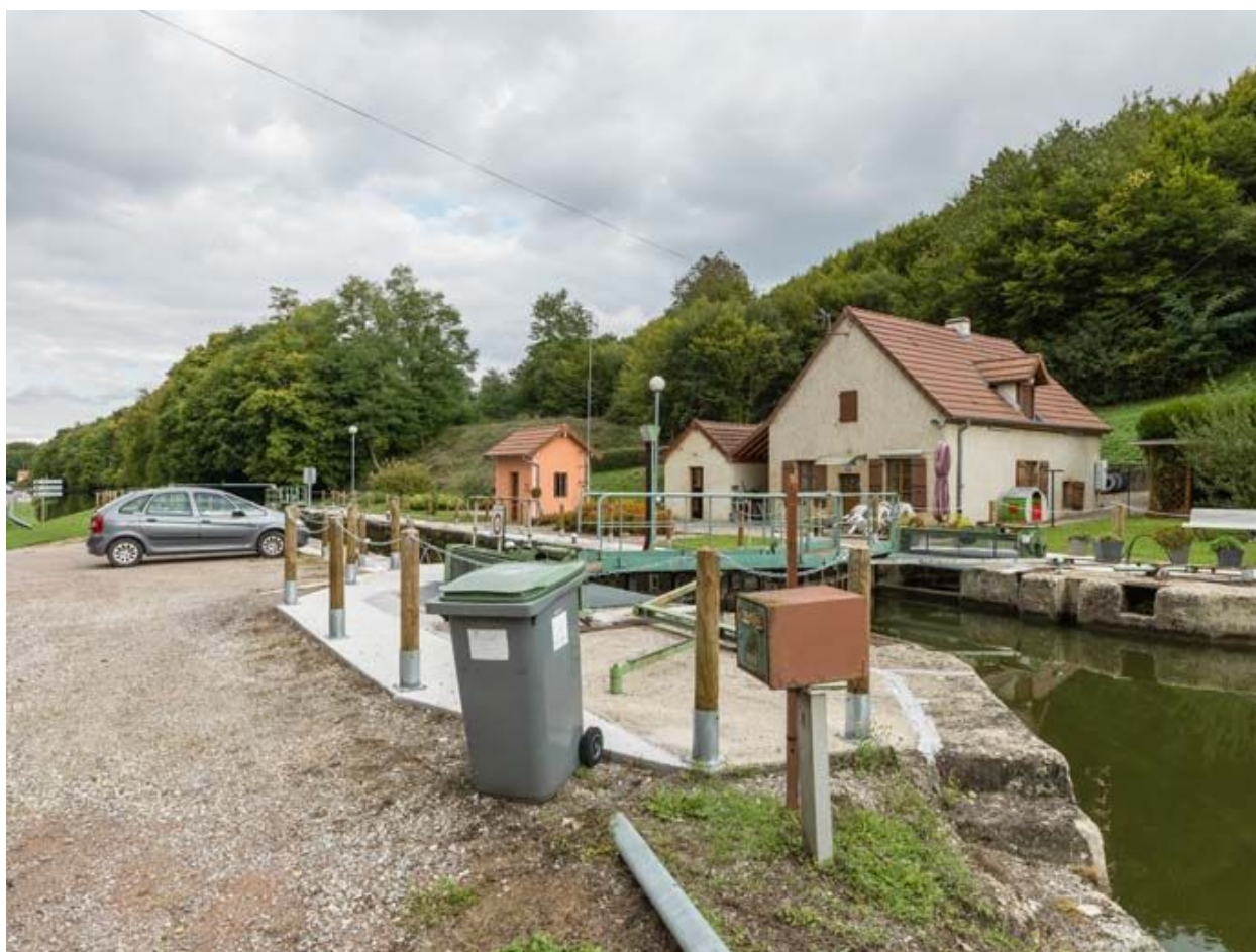
Vue d'ensemble du site d'écluse.
