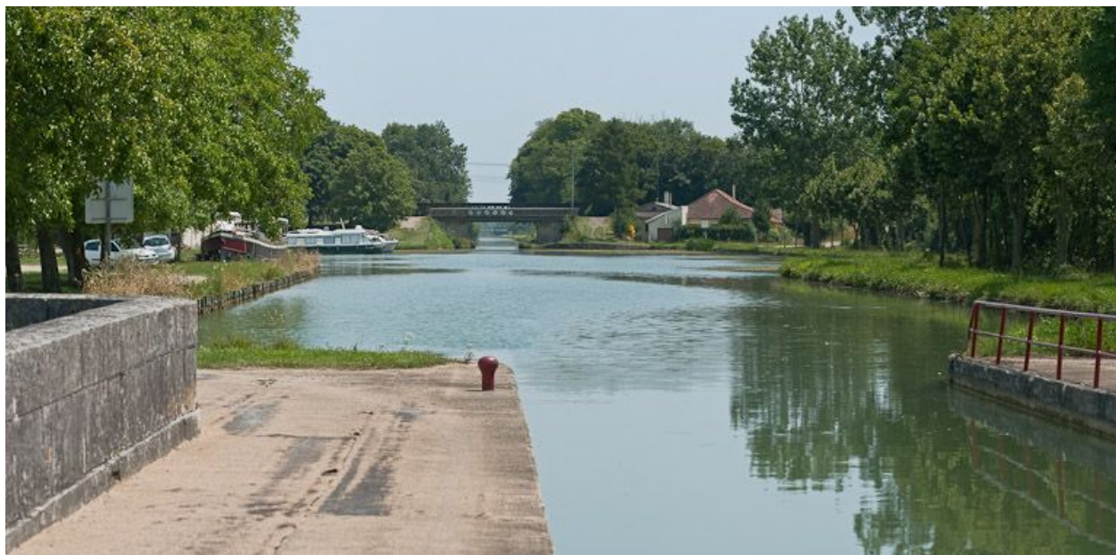
Vue d'ensemble du port.
