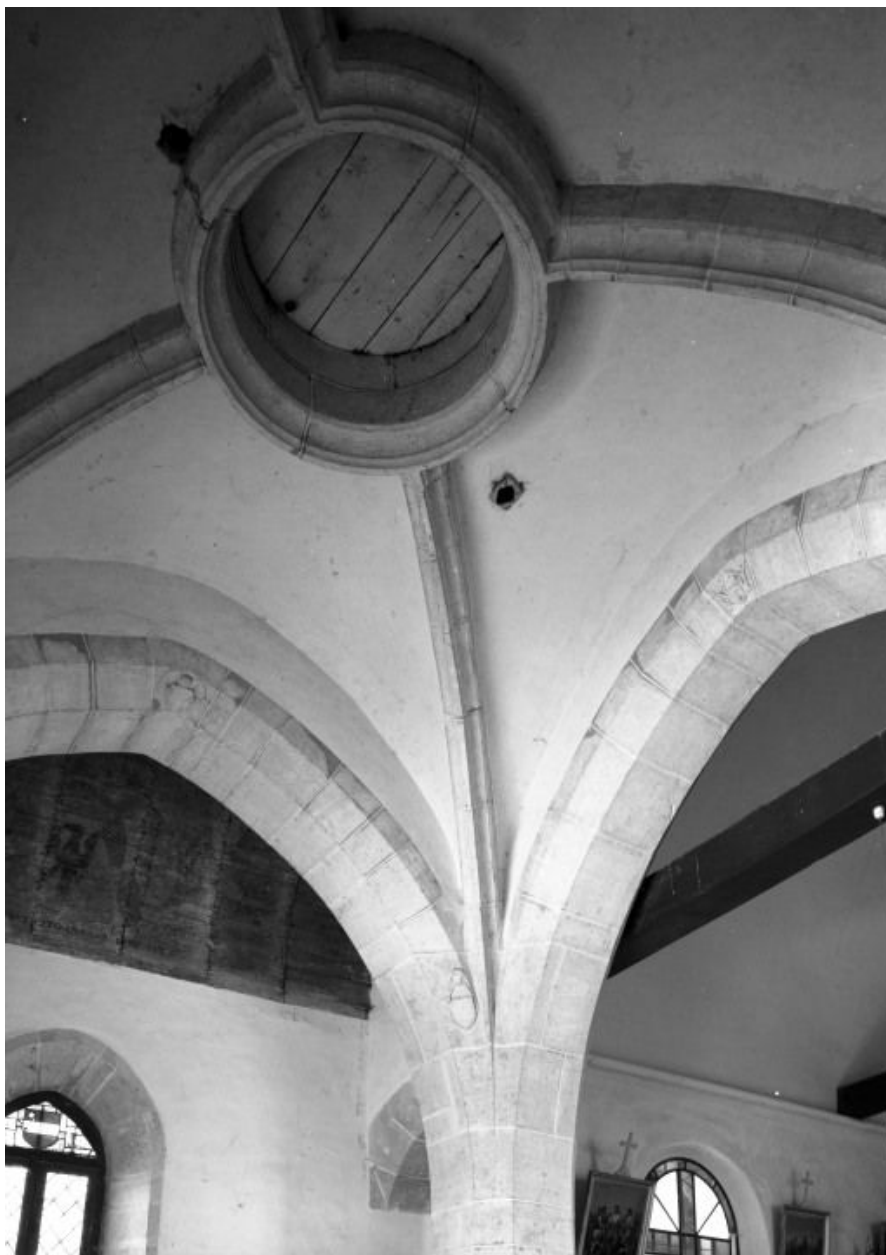
Voûte de la travée sous clocher
