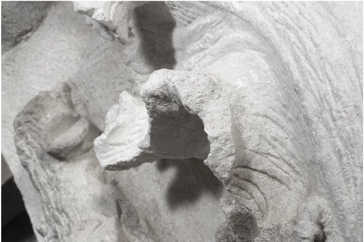
Combles : au-dessus du grand logis, partie droite. Fenêtre à montants sculptés : détail d'un montant.
