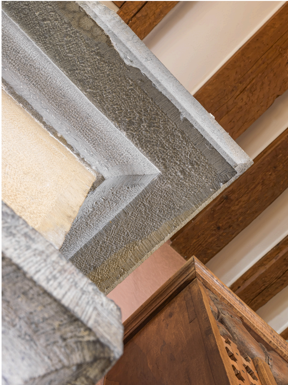
1er étage, logement destiné aux officiers : cheminée, détail du manteau.
