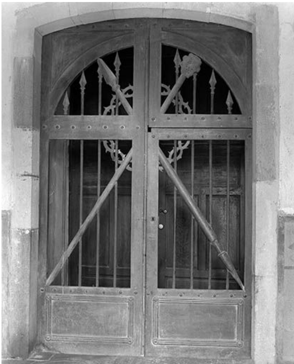
Porte conduisant à la nef.
