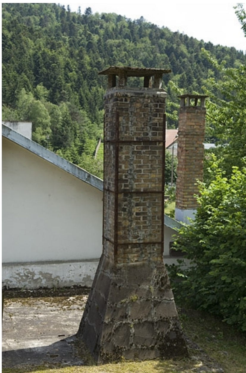
Détail d'une cheminée.
