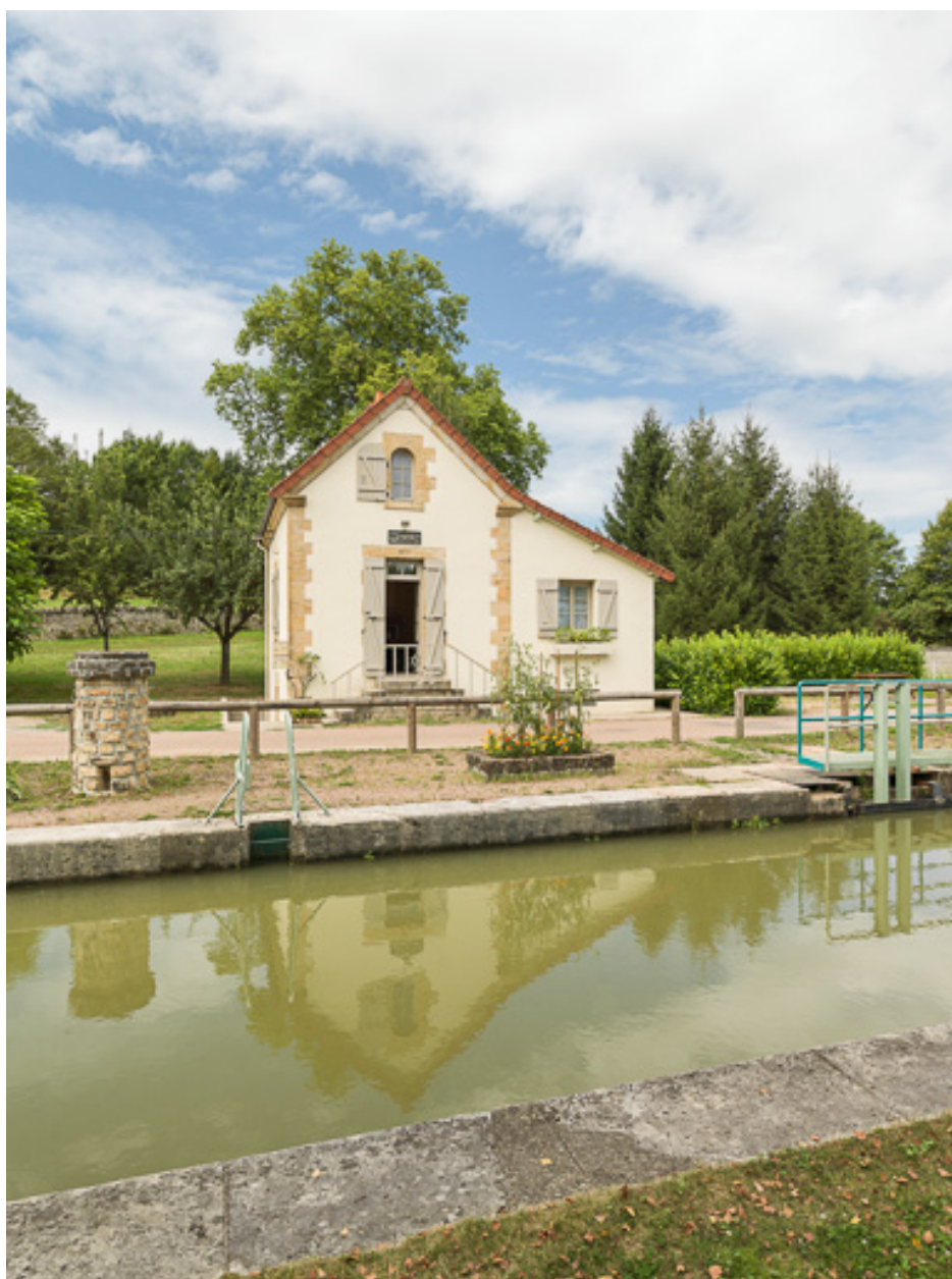
Vue de la maison éclusière.
