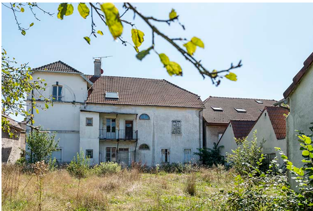
Logement : façade postérieure.
