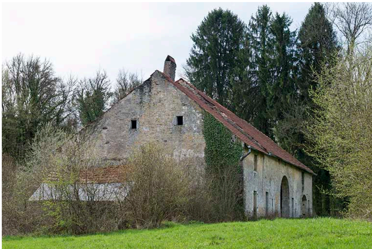
Le mur pignon nord.
