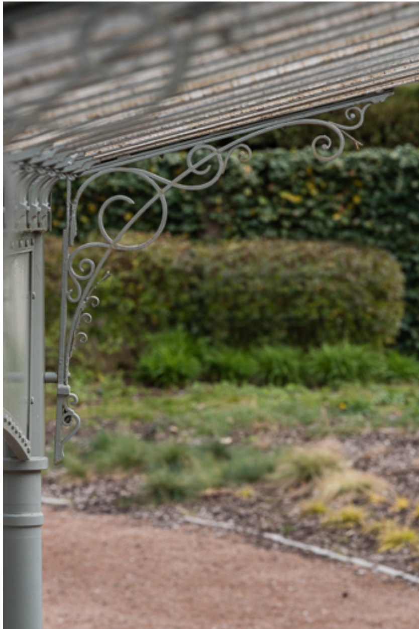
Buvette "reconstruite" à son emplacement actuel, détail de la structure d'origine.
