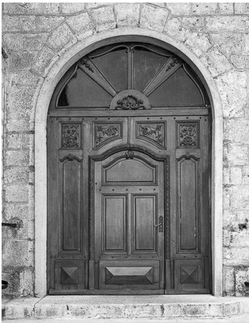
Porte d'entrée nord.
