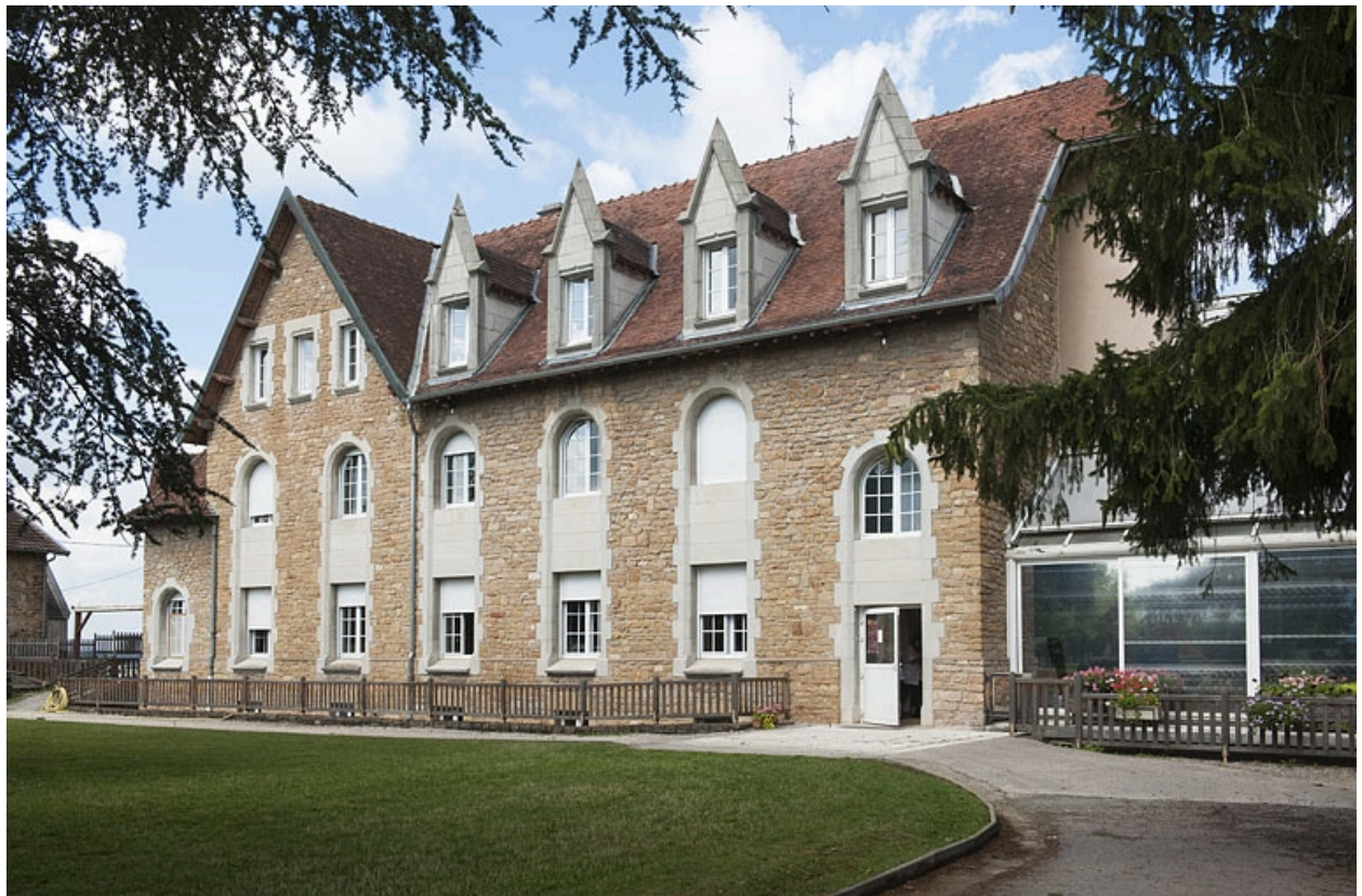
Bâtiment (G), façade postérieure, vue de trois quart droit.
