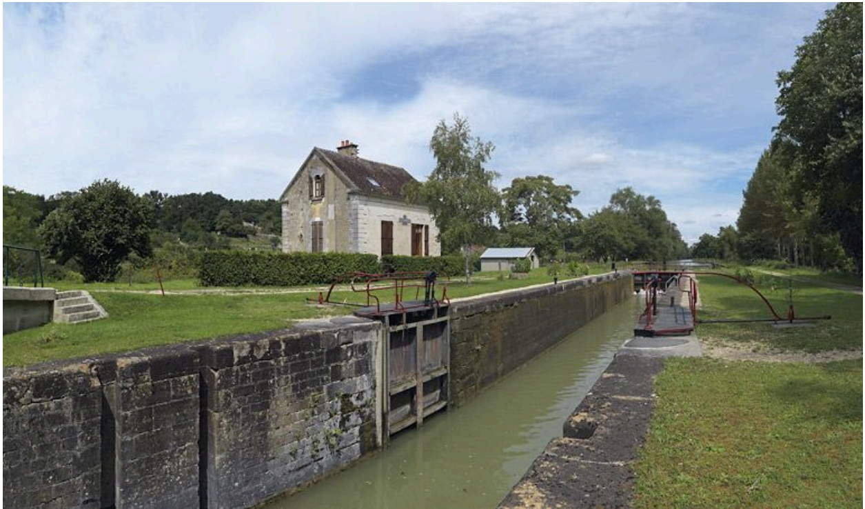
Site de l'écluse 109 du versant Yonne, dite de la Maladrerie, à Saint-Florentin : vue d'aval.
