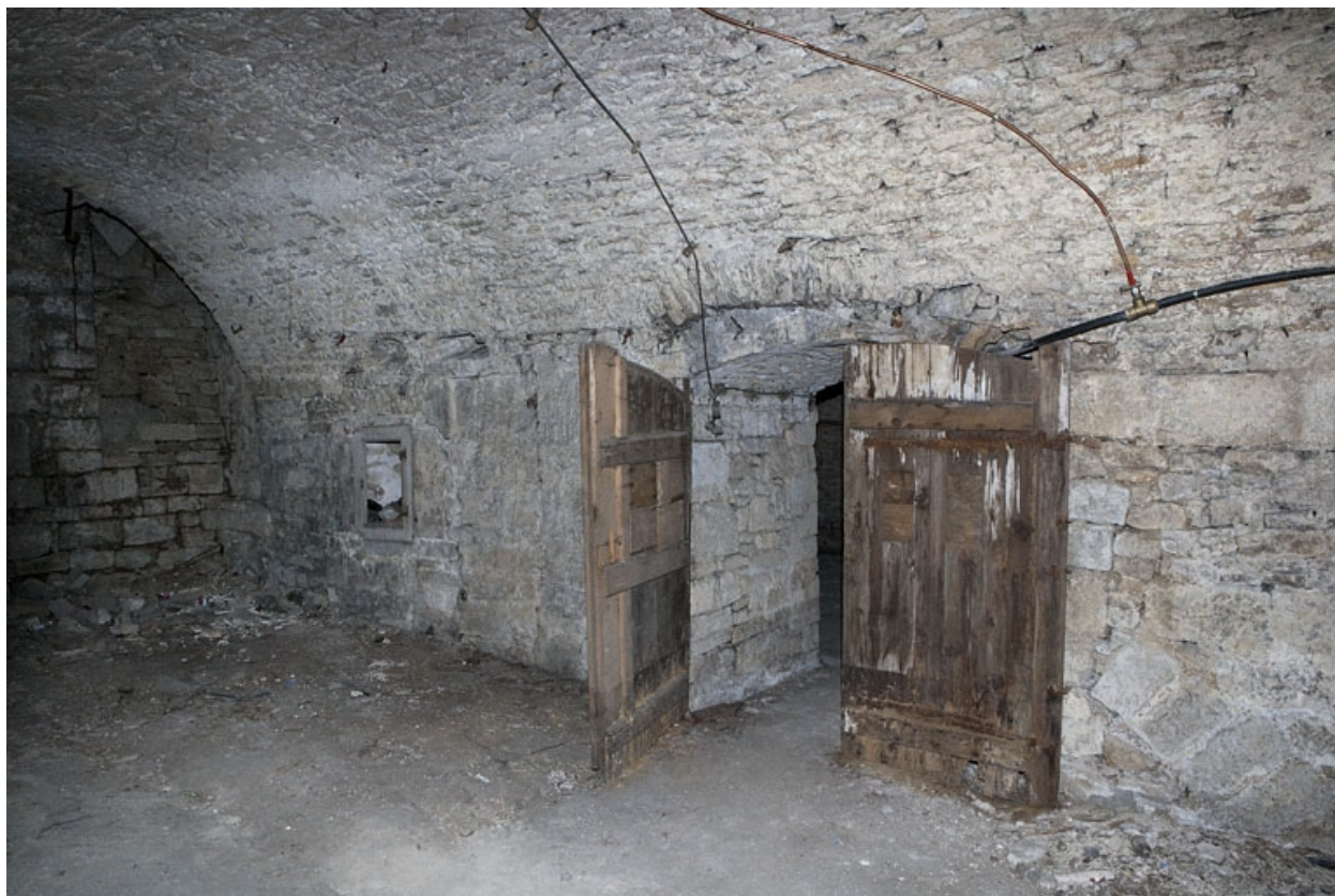
Logis principal, sous-sol : cave C.
