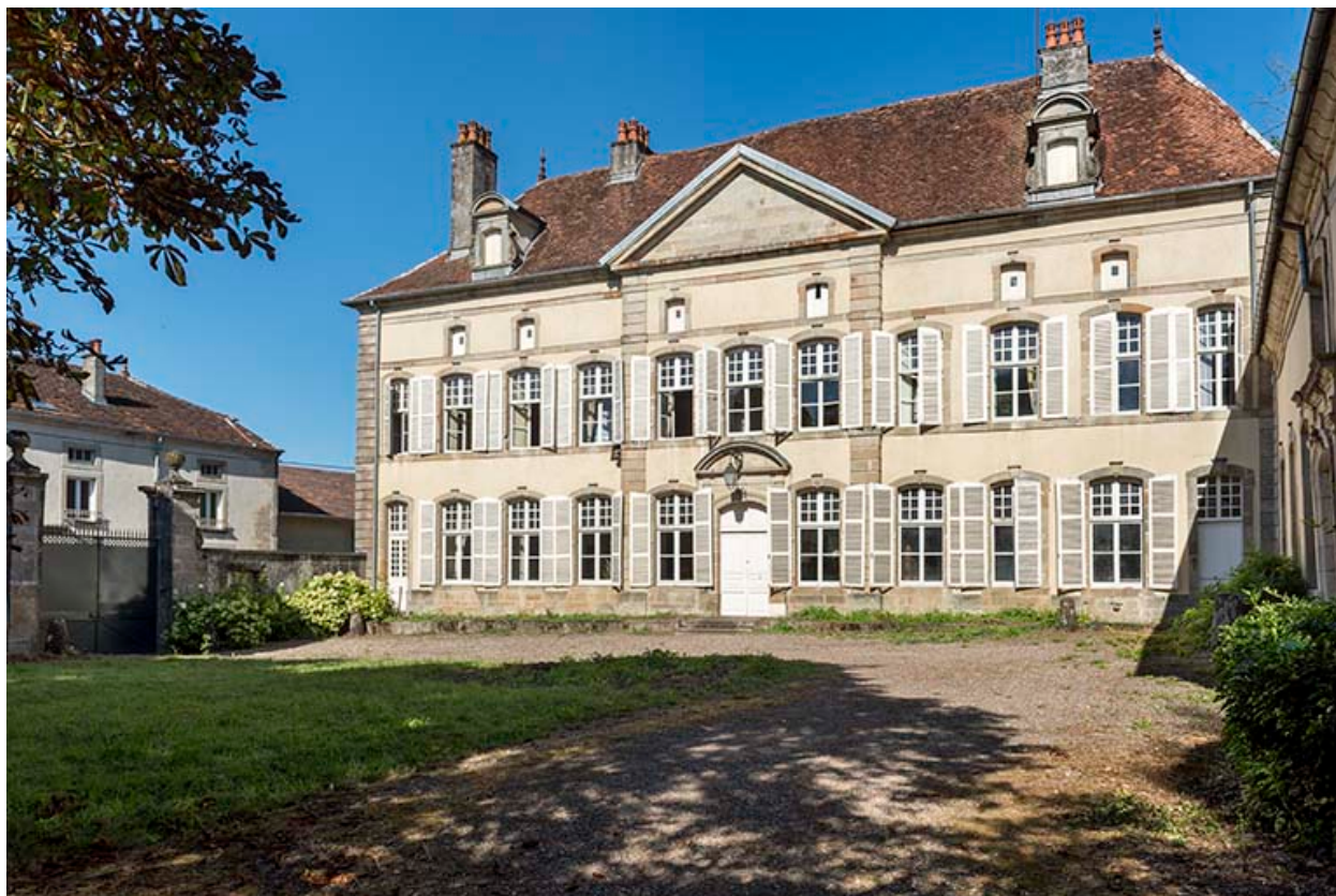
Façade principale vue de l'est.
