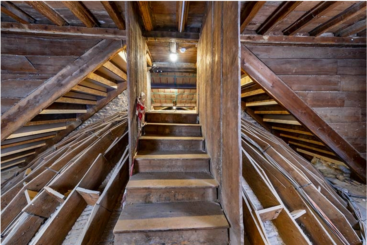
Foyer : extrados de la fausse-voûte en cul-de-four de l'antichambre, dans le comble.
