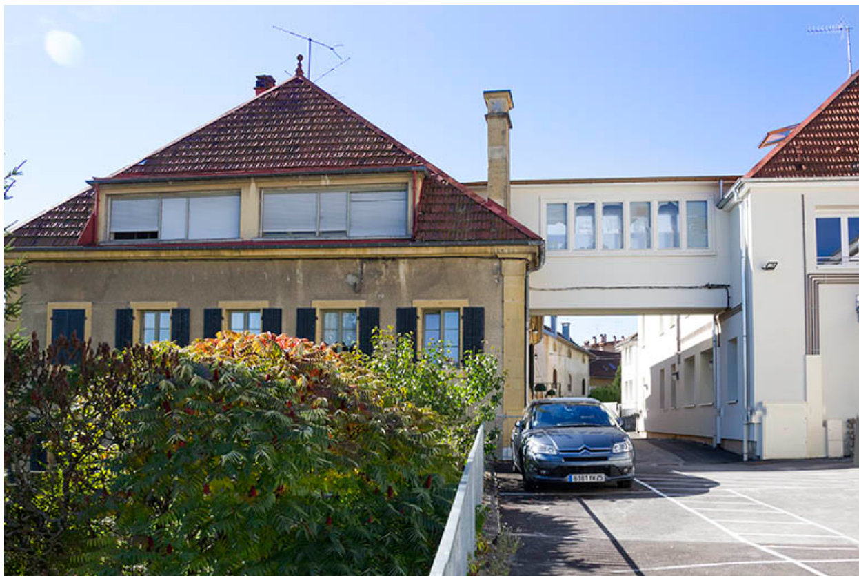
Maison : façade postérieure et passerelle.
