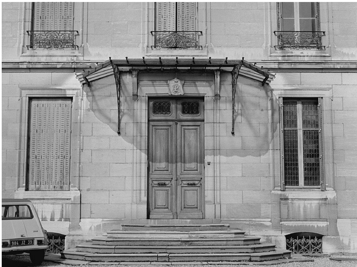
Façade antérieure, porte d'entrée.
