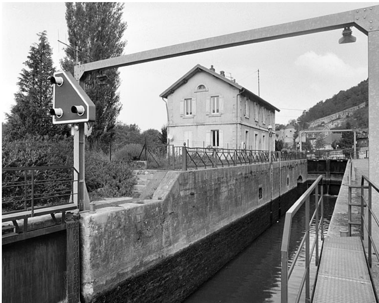
Intérieur du sas, de trois quarts.
