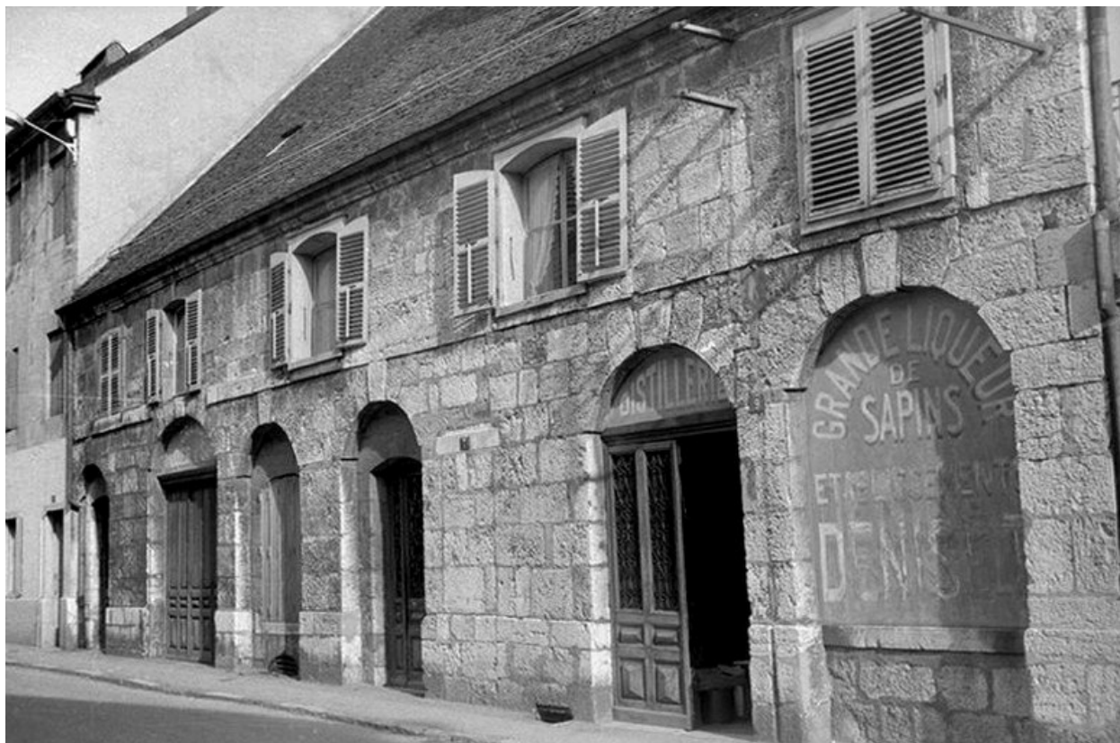
Façade ouest en 1968.
