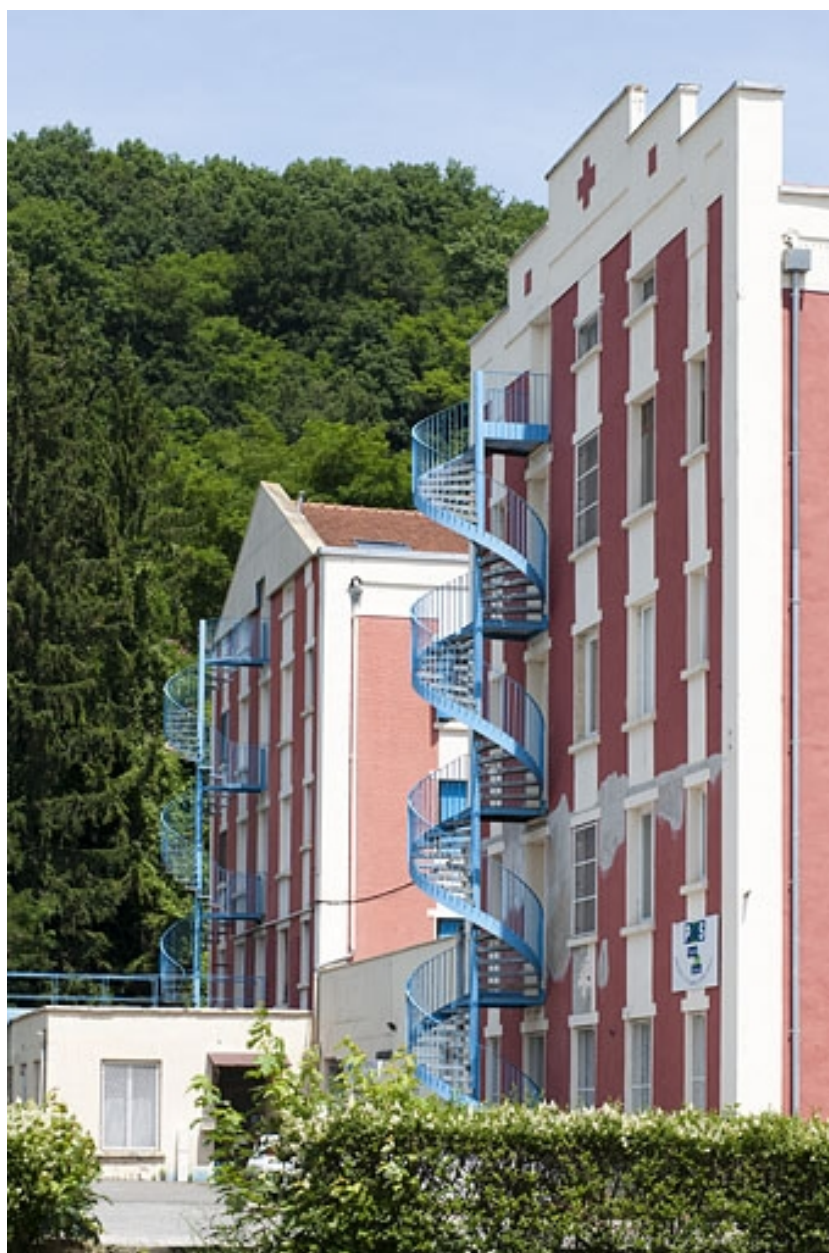
Immeubles de dortoirs. Pignons ouest.
